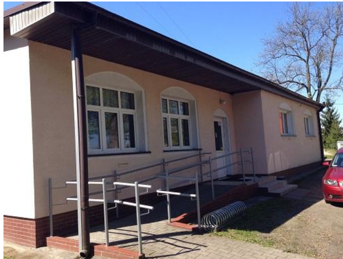
Część budynku rozbudowywana sukcesywnie w ciągu ostatnich kilkunastu lat.
