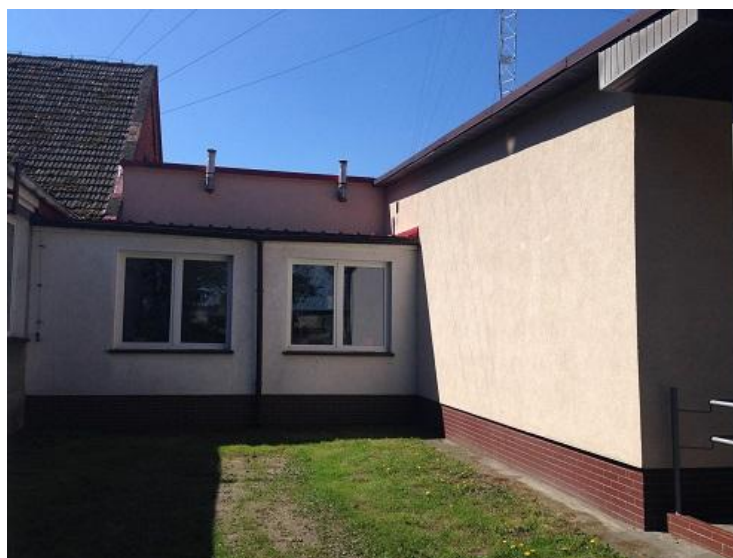
Część budynku rozbudowywana sukcesywnie w ciągu ostatnich kilkunastu lat.
