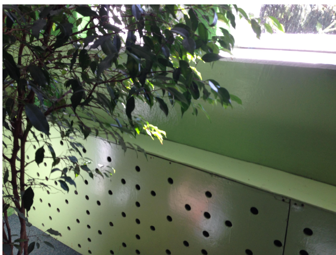
Jeden z grzejników stalowych, rurowych nieprawidłowo zabudowany.
