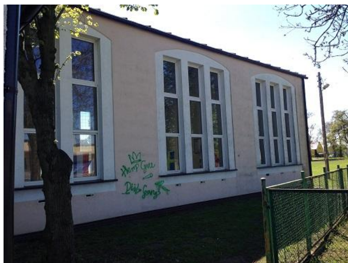
Sala gimnastyczna elewacja północno-zachodnia.
