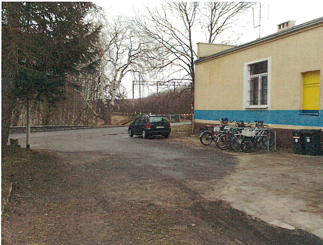
Fot. 5. Przy budynku stacyjnym
