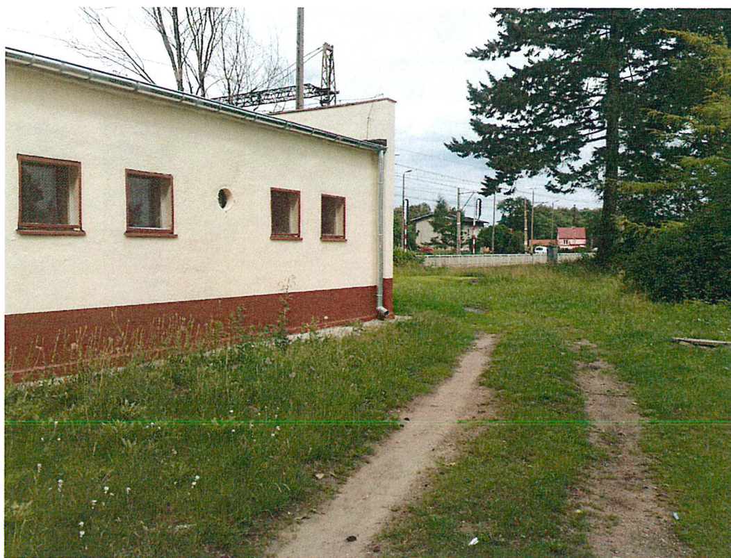
Fot. 4. Za budynkiem stacyjnym
