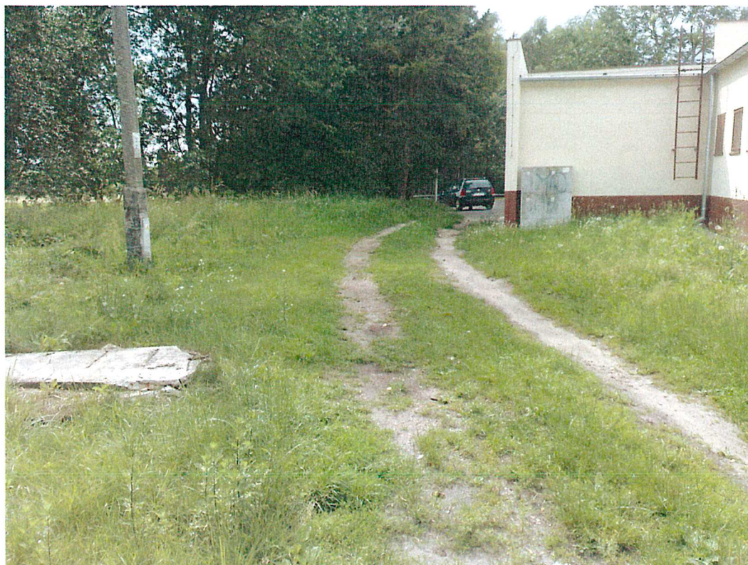
Fot. 6. Za budynkiem stacyjnym
