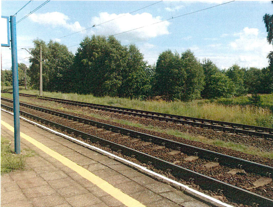
Fot. 11. Widok z peronu na teren pod planowaną inwestycję
