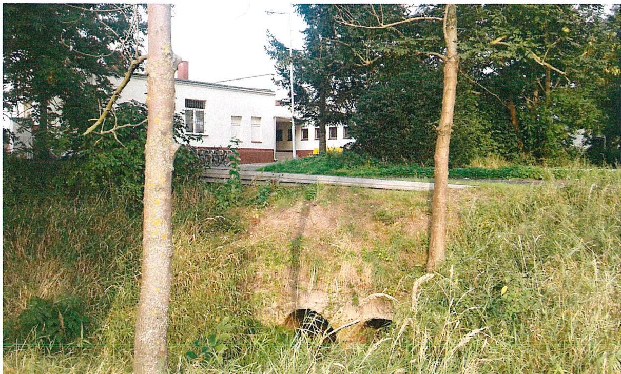
Fot. 16. Przepust dla rz. Miedwinki na drodze powiatowej, widoczny budynek stacyjny
