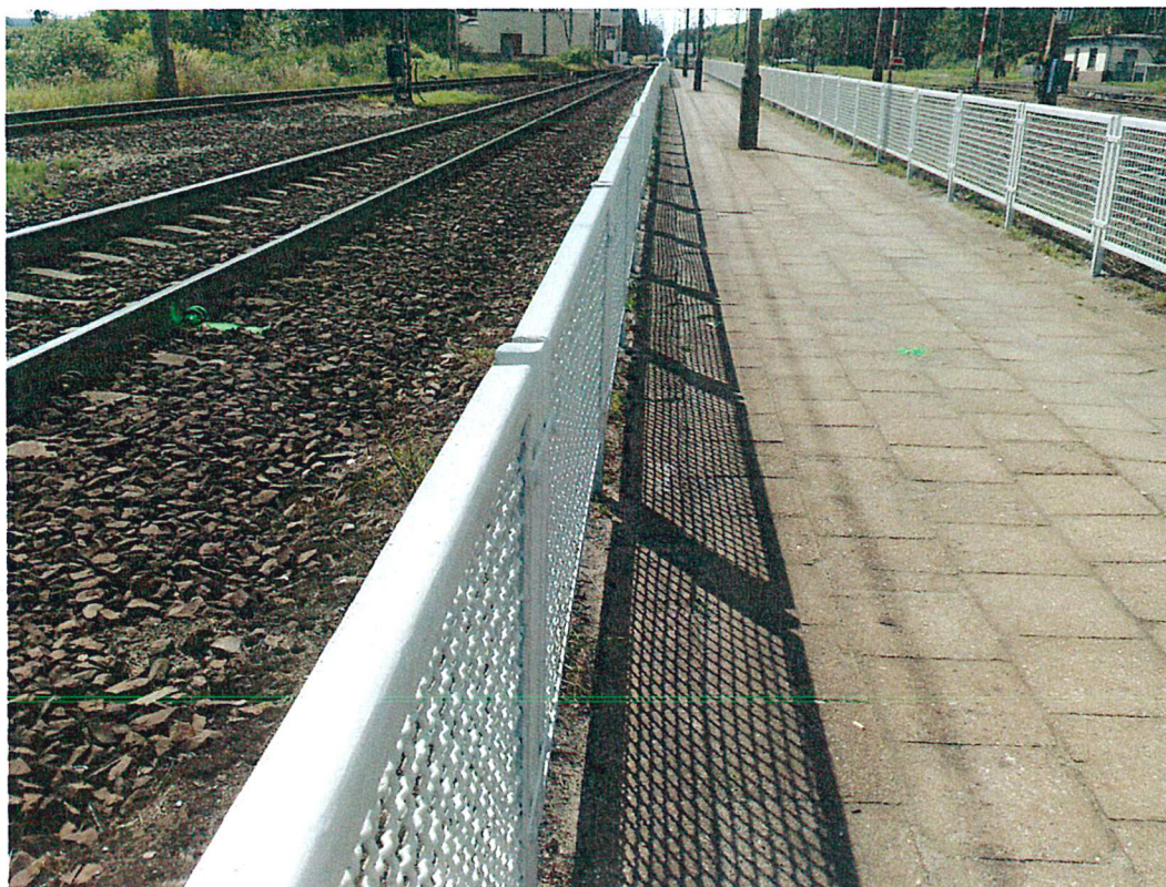
Fot. 10. Dojście do peronu, w połowie wysokości fotografii widoczny punkt z odległością km 185,58
